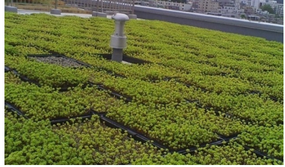
平成22年9月状況 施工後無灌水
