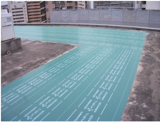
耐根シート取付(耐根フィルムの場合は見切り材取付後)
