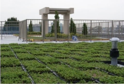
平成21年10月施工 東京都品川区 (トレイ工法)
