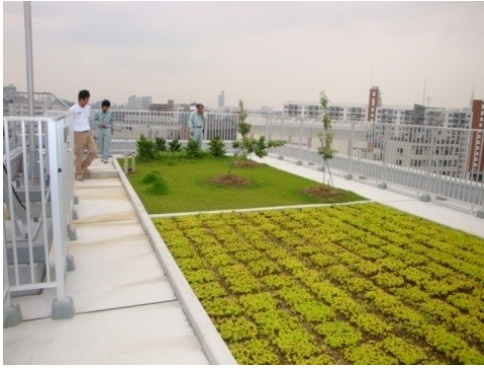
江東区 ミドリレンゲ部 無灌水 (マット&セル苗植栽工法)
