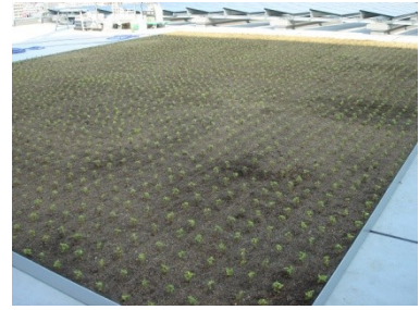
都内駅ビル屋上(セル苗植栽工法)
