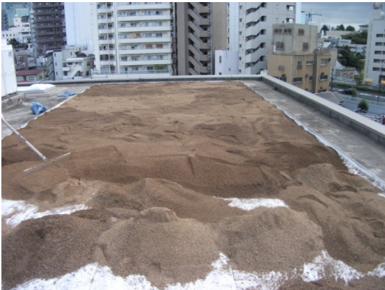
軽量土壌IGソイル- II 敷き均し
