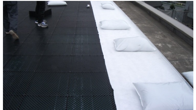
透水シート取付
